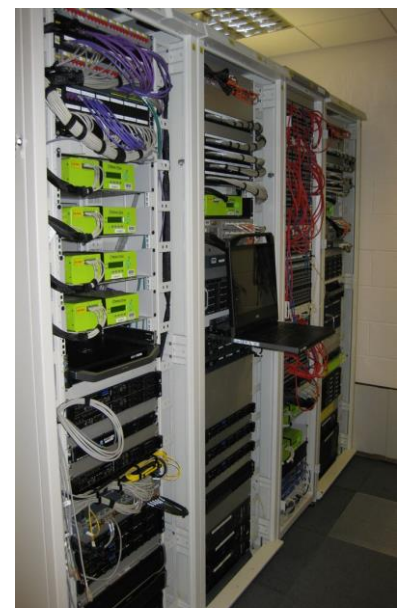
NE-ONE Professional und NE-ONE Enterprise Netzwerk-Emulatoren (grüne Appliances) sind ein integraler Bestandteil des LSRC-Testaufbaus
